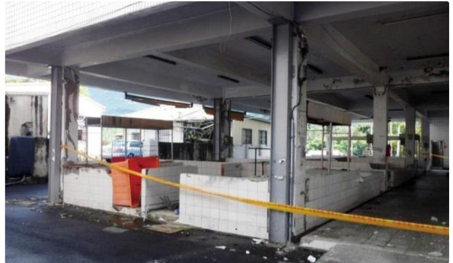
某公有市場於2016年美濃地震前已施作簡易補強，地震時明顯發揮抗倒塌效果。
