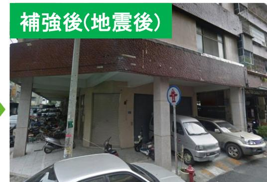
美濃地震前完成簡易補強，地震後雖有結構性損壞，但未倒塌。
