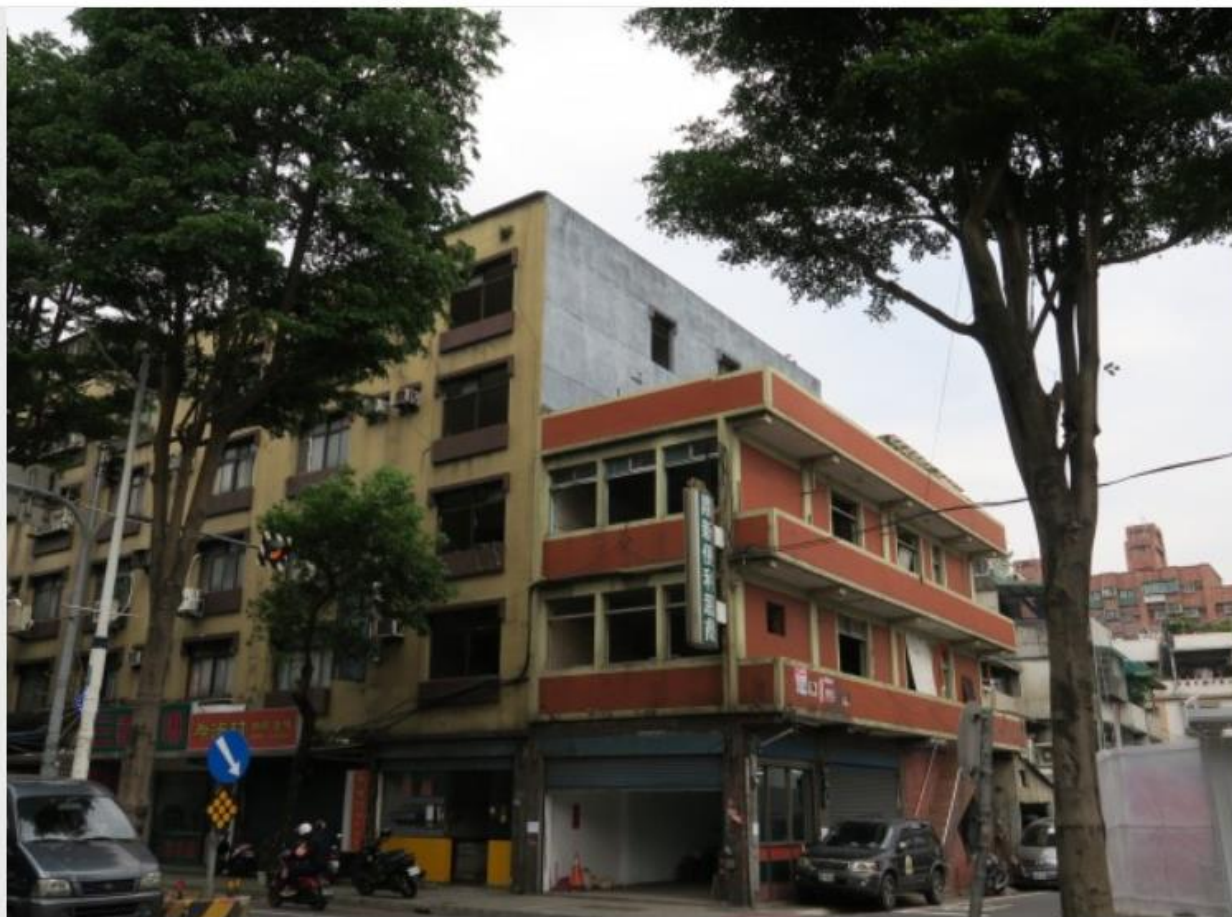
新北市政府今天再核准四案危老重建計畫，其中樹林區大同段的老屋今天拆除。(都市更新處提供)
